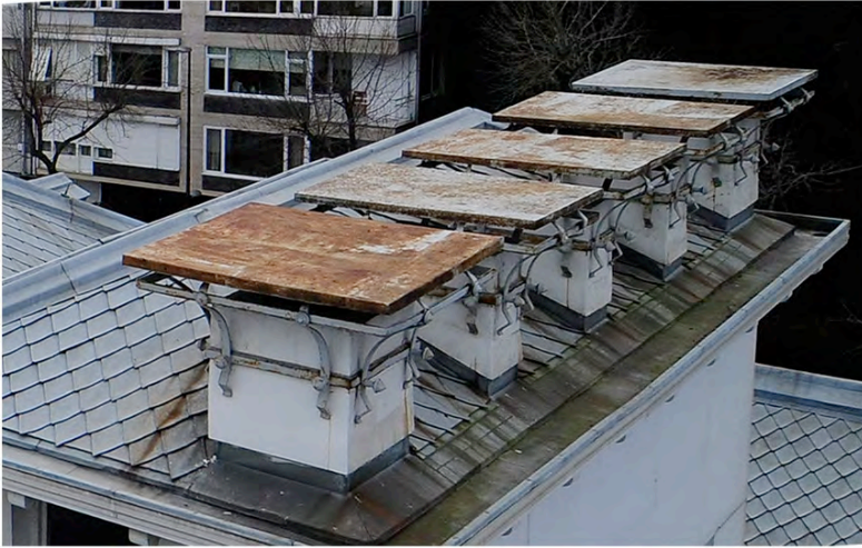
16. Yapının eski fotoğrafında görülen duruma göre değiştirilen baca bitişleri
