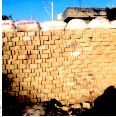
2. Nusaybin Abdülkadir Paşa Mahallesi yaşayanları tarafından tuğlalardan örülen bu duvarlar mimari unsur olarak nekrosiyate karşı direnç mimarlığı örneği. 2016’da bu bölge imha edildi, 6.000 kadar bina yıkıldı, 30 bin kişi evlerini kaybetti. Bu bölgede devlet hızlı bir şekilde yeni lüks konut alanları inşa etti.
