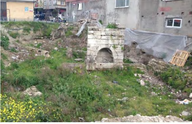
10. 2014 yılında çeşme ve çevresinin görünümü (Çeşme etrafındaki dolgunun kaldırılması sonucu çeşme bileşenleri ve çeşmeye ait temiz su tesisatı ortaya çıkarılmıştır)
