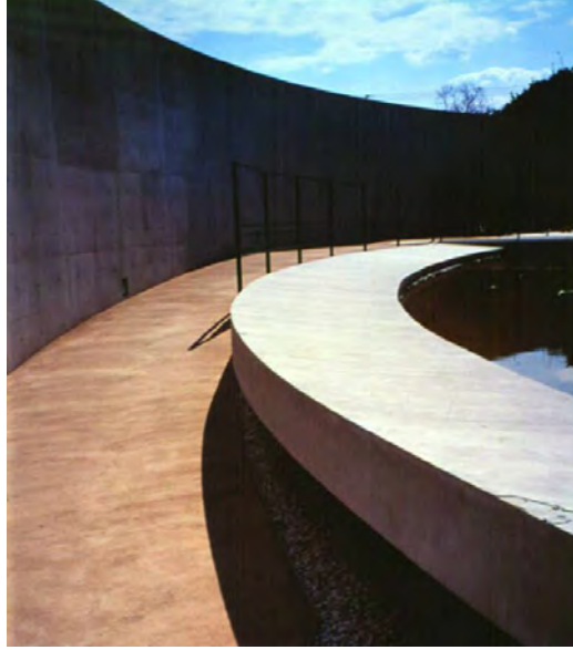
15. Awaji Yumebutai yapısı
