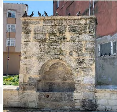
12. Çeşmenin restorasyonu sırasında tamir harçları yapılarak derz boşlukları ve taşlardaki eksiklikler kapatılmıştır
