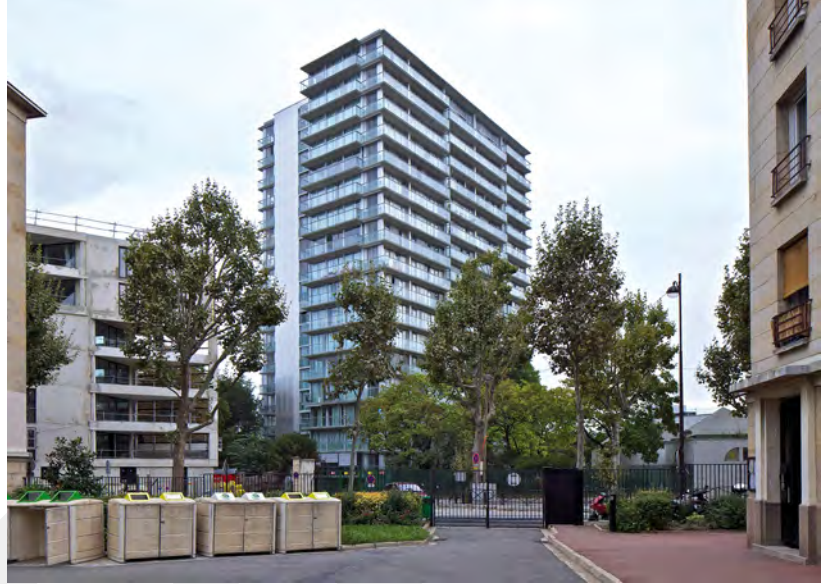
3. Paris 17° Tour Bois le Prêtre konut bloğu dönüşümü, cephe
